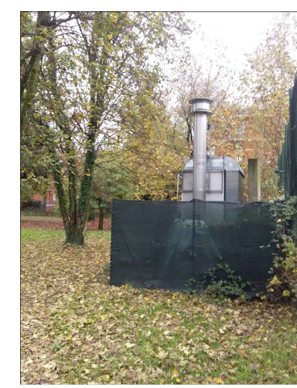
RIMOZIONE CENTRALE TERMICA
